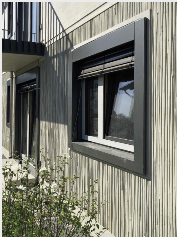
Abb. 16.2: Detailansicht der Fassade mit Rillenstruktur
