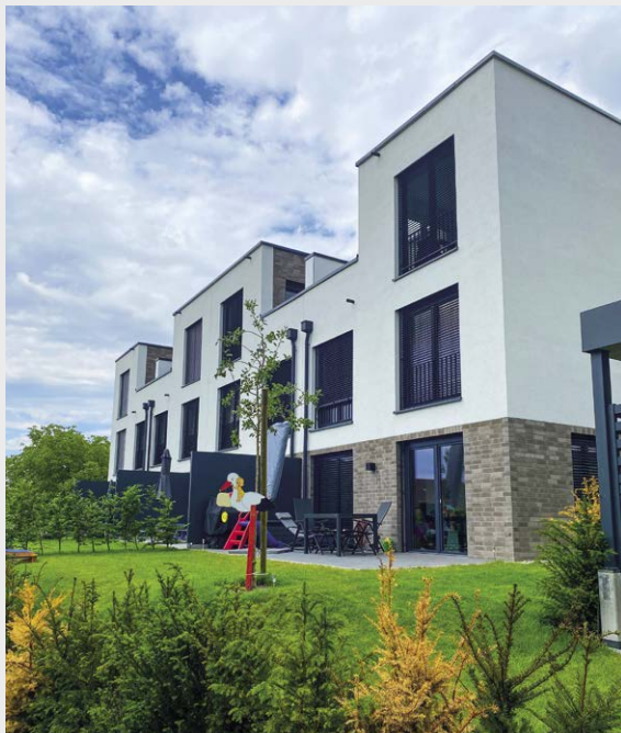
Abb. 16.7: Moderner, serieller Wohnungsbau mit Betonfertigteilen
