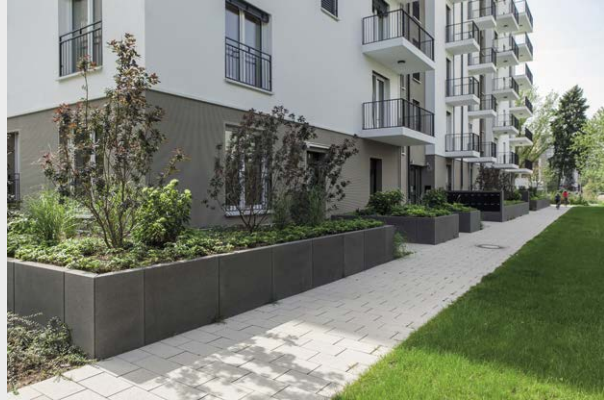
Abb. 16.21: Betonsteinpflaster ermöglichen sichere und gepflegte Zugangswege.
