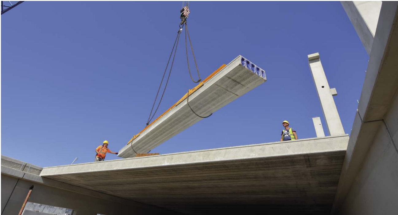
Abb. 3.3: Verlegung von Spannbeton-Fertigdecken
