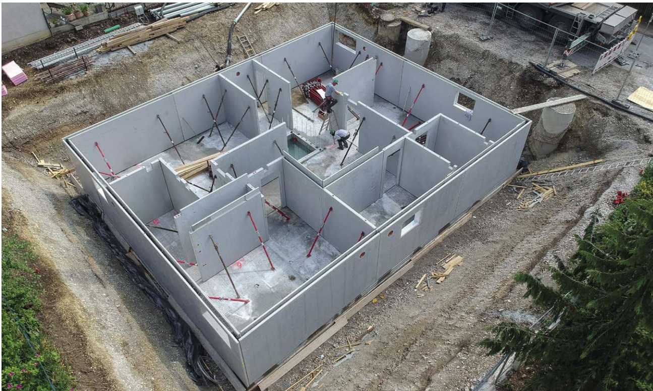
Abb. 9.1: Fertiggeller aus vorgefertigten Betonelementen verkürzen die Bauzeit.
