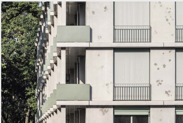
Abb. 16.17: Die Fassade und Balkone sind aus Betonfertigteilen.
