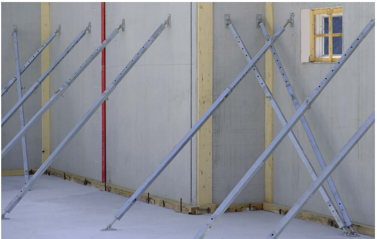
Abb. 4.2: Abstützen und Abschalung von Elementwänden vor Einbringen des Ortbetons
