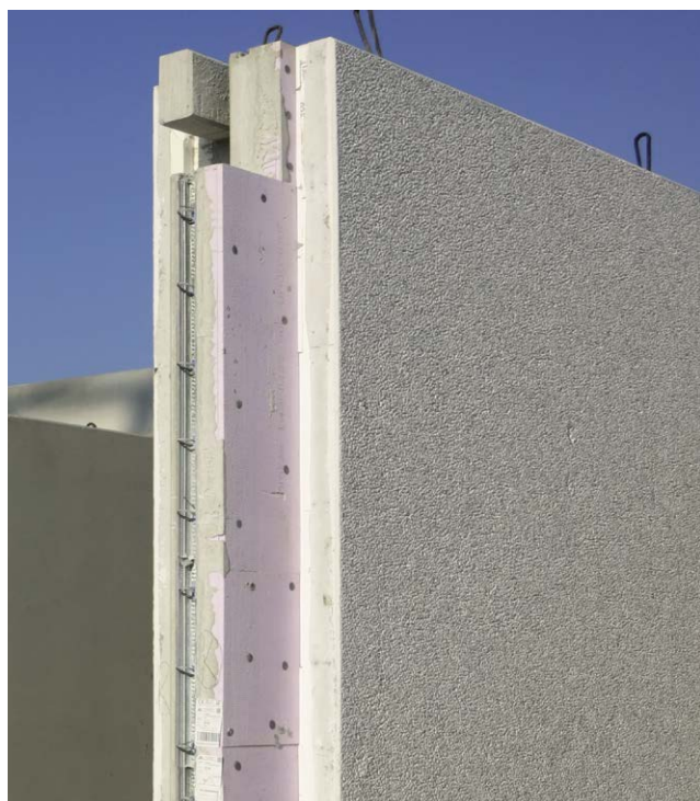
Abb. 5.4: Detailansicht einer Sandwichwand
