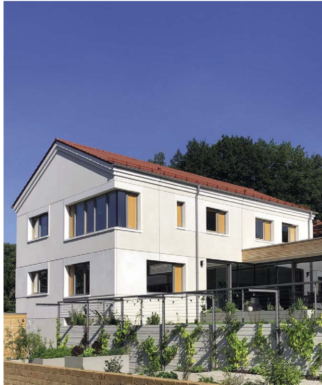
Abb. 5.3: Wohnhaus mit Fassade aus Sandwichelementen
