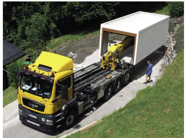
Abb. 11.2: Spezielle Versetzfahrzeuge bringen die Betonfertiggarage zur Baustelle und stellen diese direkt auf.
