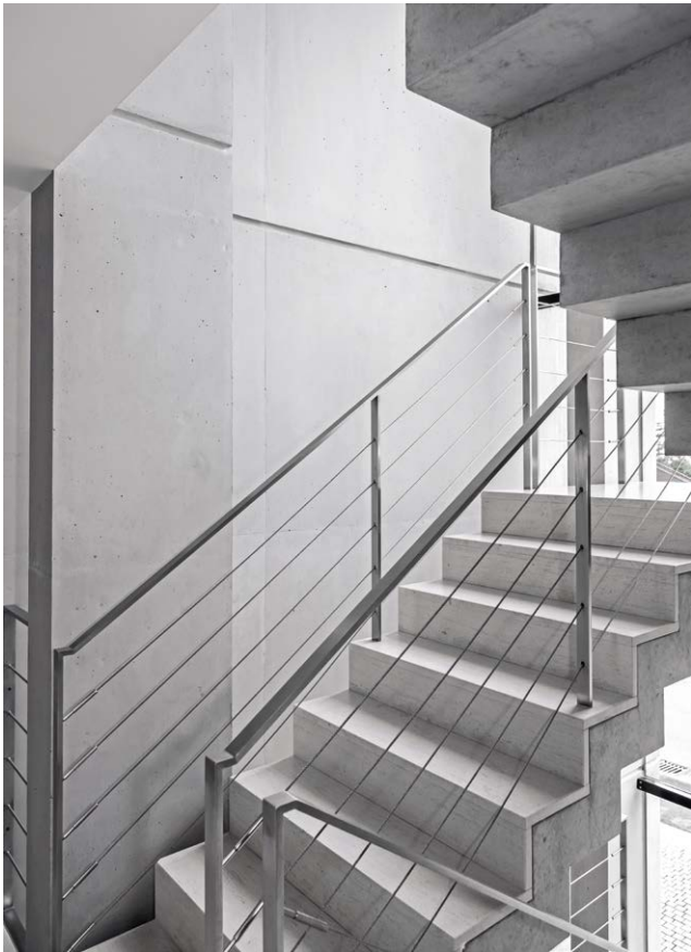
Abb. 7.3: Betonfertigteiltreppe mit Belag aus Betonwerkstein
