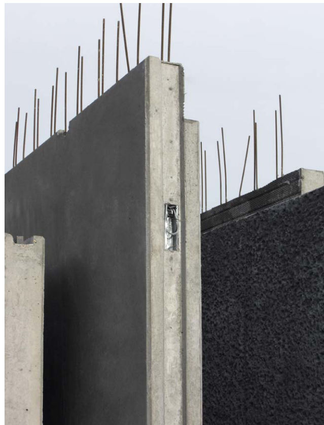
Abb. 4.1: Massive Wandelemente mit Anschlussbewehrung
