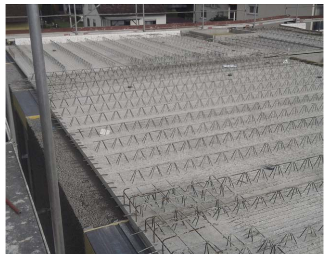
Abb. 3.2: Elementdecke fertig verlegt
