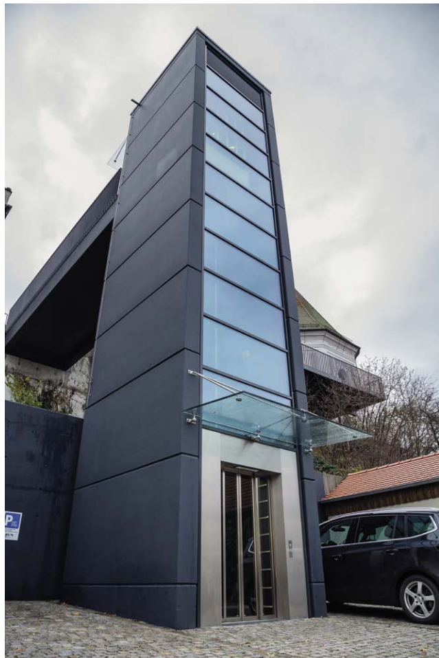
Abb. 7.4: Aufzugsschacht aus vorgefertigten Betonelementen
