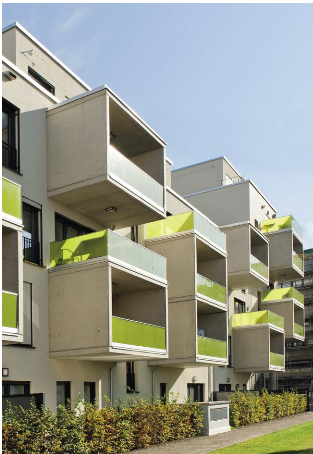
Abb. 8.1: Fertigbalkone aus Beton sind stabil und bieten maximale Flexibilität.
