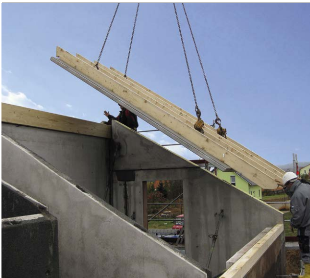
Abb. 10.1: Einbau eines Massivdaches
