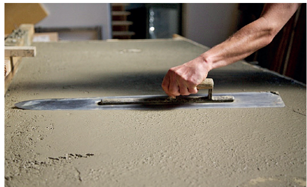
Abbildung 2: Händisches Glätten einer ungeschalteten Einfüllseite, Quelle: Hemmerlein Ingenieurbau GmbH
